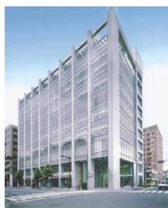
日本橋安田スカイゲート 竣工：2003年 規模：地上10階 用途：オフィス、住宅、店舗
