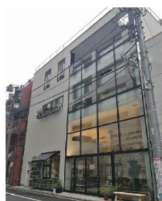
Hama House 竣工：2017年 規模：地上3階 用途：店舗、オフィス
