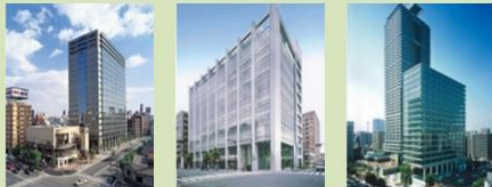
日本橋浜町Fタワー 1997年竣工 日本橋安田スカイゲート 2003年竣工 トルナーレ日本橋浜町 2005年竣工
