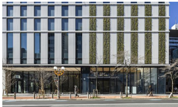
▲ 外観（オフィスエントランス）
