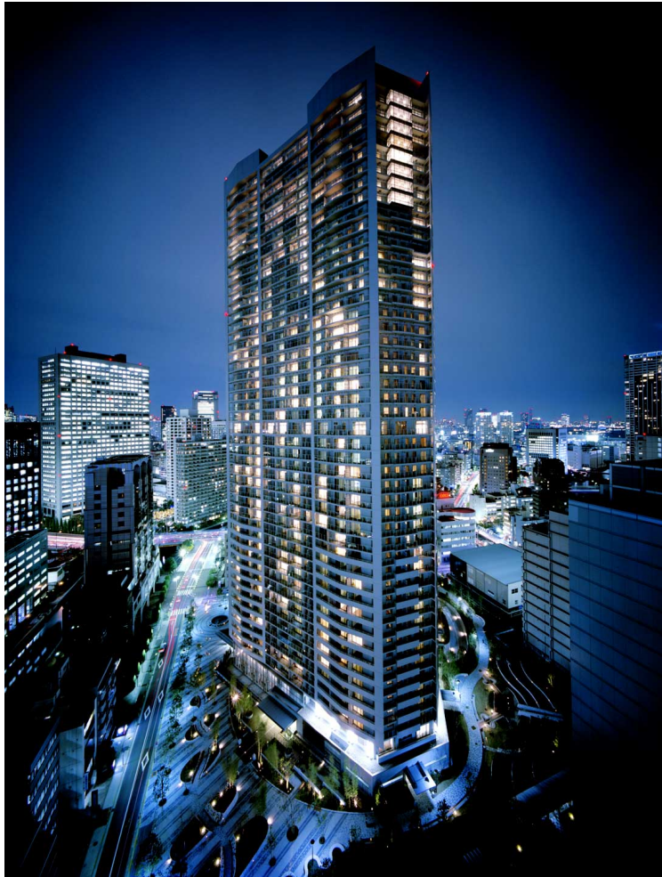
【建物外観(夜景)・・・南西側より】
